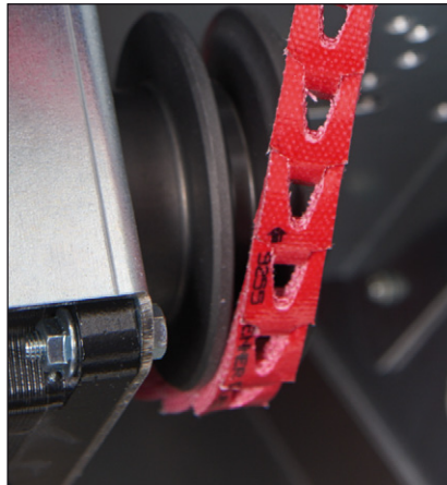
Bei der Montage des Antriebsriemens ist auf die Drehrichtung der Speichermasse zu achten. Die Laufrichtung ist auf den Riemenelementen durch ein Pfeil gekennzeichnet
