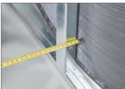
(11) Kontrollieren Sie die Zentrierung des Wärmerades in der vertikalen Gehäusemitte, Messpunkte siehe (9) auf beiden Seiten.
