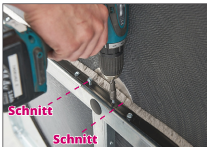
(4) Durchtrennen Sie die Bürstendichtung wie im Bild markiert und lösen Sie die Befestigungsschrauben der Lagerabdeckung
